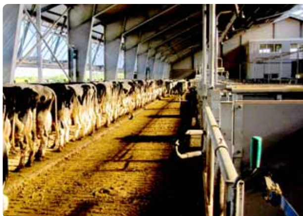
Et bredt spaltegulvsareal, her 260 cm, mod en lukket front til sengebåse. Her vist med kvier i de beskyttede ædebåse i en ny løsdriftstald til 280 køer med fire robotter.
