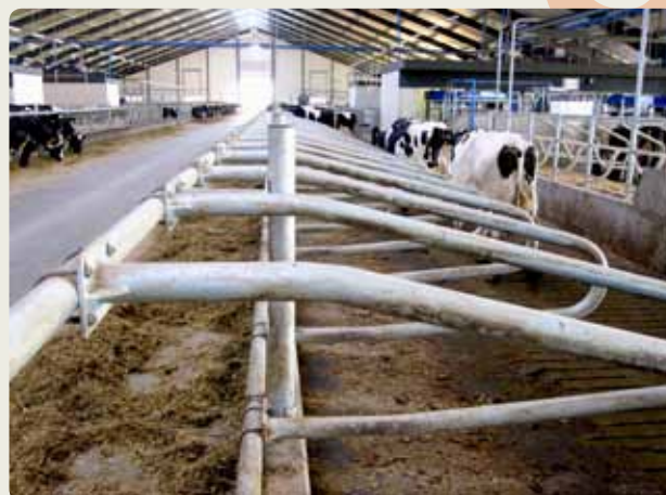
Ædebåse med ædebøjler ses monteret på et fremskudt nakkerør over foderbordet i ny løsdriftsstald til 500 køer. Der er indlagt gummigulv i ædebåsene. Bag ædebåsene renses med skraberobot på et spaltegulv, der ligger over ringkanaler med forsuring.
