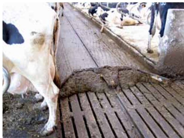
Fast gulv og gødningskraber bag senge- og ædebåse i nyopført løsdriftstald til 126 køer og to robotter.
