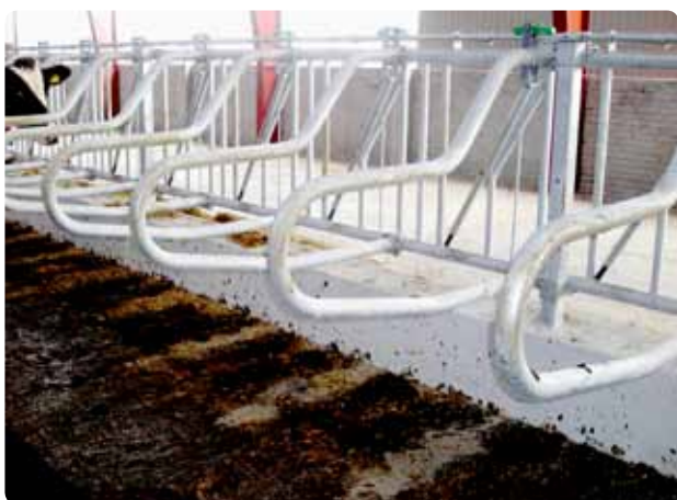
Ædebøjler monteret på lodret fanggitter i nyopført løsdriftstald.
