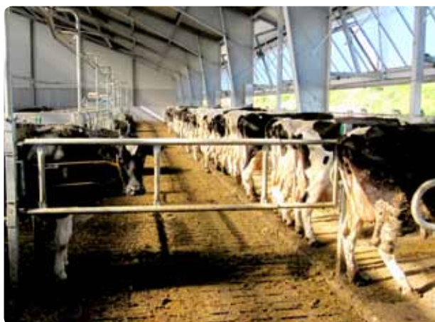
Areal med spaltegulv bag malkekøer i ædebåse i nyopført stald. Resterende gulvareal i foderarealet fremstår nu som et relativt tørt, urin og gødningsfrit gulvareal i stalden bag foderbordet.
