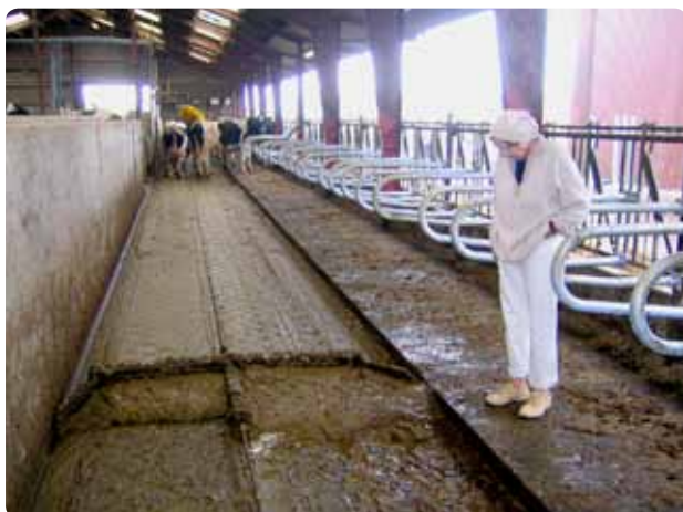
Ombygget løsdriftstald med 180 køer og tre robotter, nu med beskyttede ædebåse, gummigulv og ædebøjler monteret på det eksisterende gamle lodrette fanggitter.
